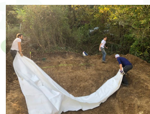
Pose de feutre pour protection de bâche
