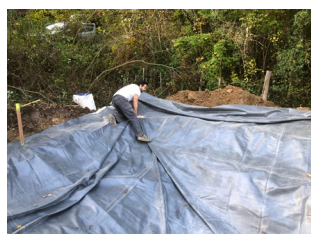
Pose de la bâche pour assurer l'étanchéité de la mare
