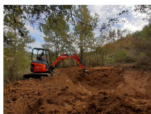
Creusement à la pelle mécanique
