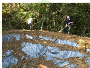
Apport de terre pour recouvrir la bâche et faciliter la végétalisation
